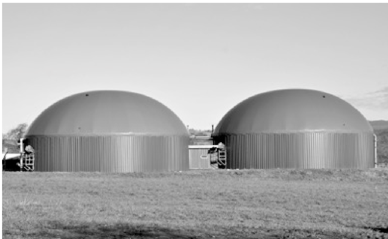
In diesen Fermentern entsteht das Biogas. (Foto: AGORA)
